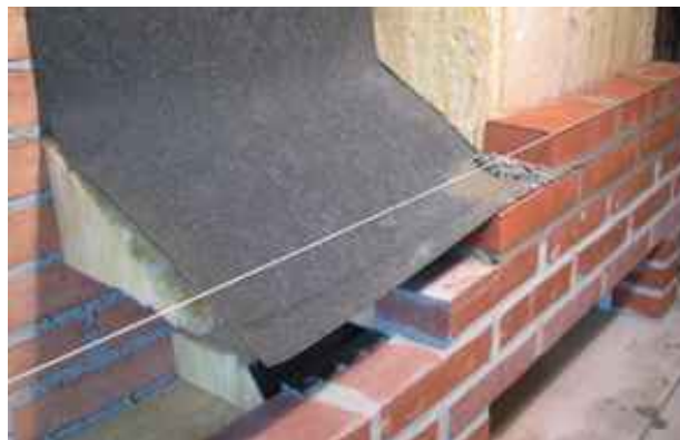
Figur 2. En hulmur består foruden murværk af bagmur, som kan være et andet materiale, isoleringsmateriale, stålkomponenter i form af bindere og evt. konsoller, murpap og såkaldte TB-render i plast. Foto: Teknologisk Institut
